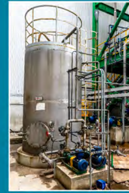
氨罐脱硝 / Ammonia DeNO x
